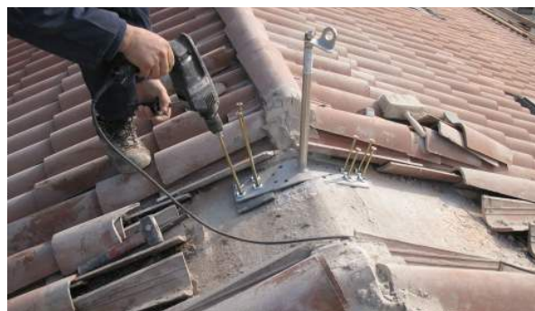
17. Installazione punto di ancoraggio
