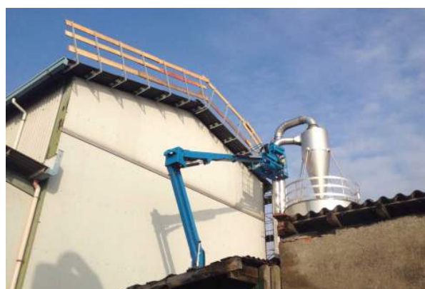
6. Montaggio parapetti con PLE
