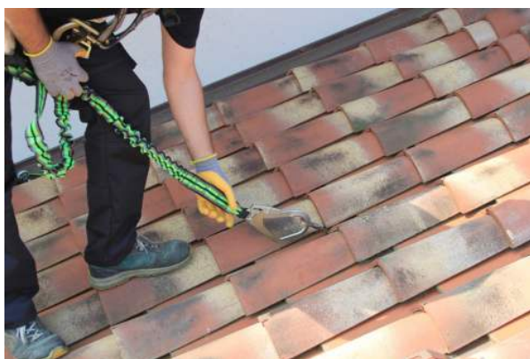
15. Collegamento all'ancoraggio
